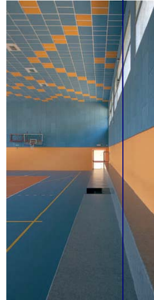
Esempi di correzione acustica in una palestra mediante rivestimenti fonoassorbenti (resistenti alle pallonate) posti a soffitto ed alle pareti
