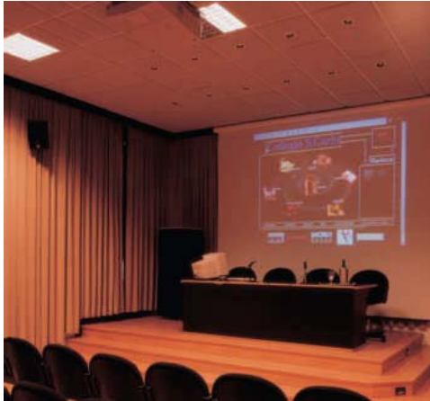
es. di insonorizzazione di una sala conferenze dotata di impianto di amplificazione vocale (pannelli fonoisolanti a soffitto, tendaggi plissettati alle pareti)
