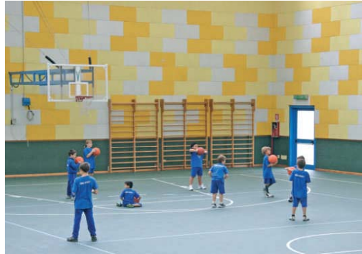
Esempi di correzione acustica in una palestra mediante rivestimenti fonoassorbenti (resistenti alle pallonate) posti a soffitto ed alle pareti
